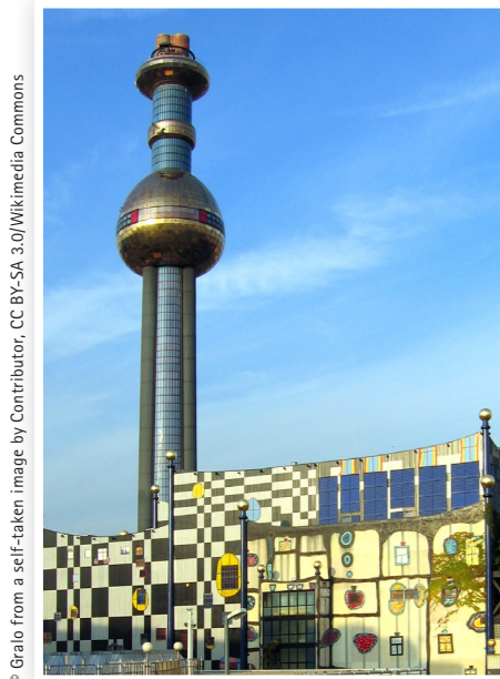
Die Müllverbrennung in Spittelau wandelt jährlich 250.000 Tonnen Hausmüll in Wärme und Strom um.
