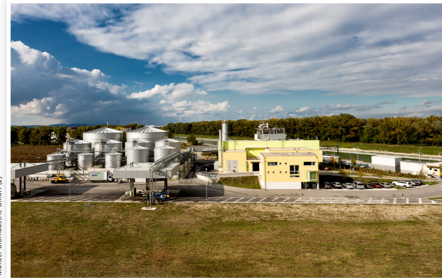
Die größte Biodiesel-Produktionsanlage Zentraleuropas im Wiener Ölhafen Lobau
