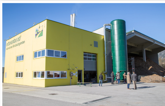
Das Heizwerk Windischgarsten ist eines von 500 Biomasseheizwerken, die zahlreiche Gemeinden in Oberösterreich mit Fernwärme versorgen.
