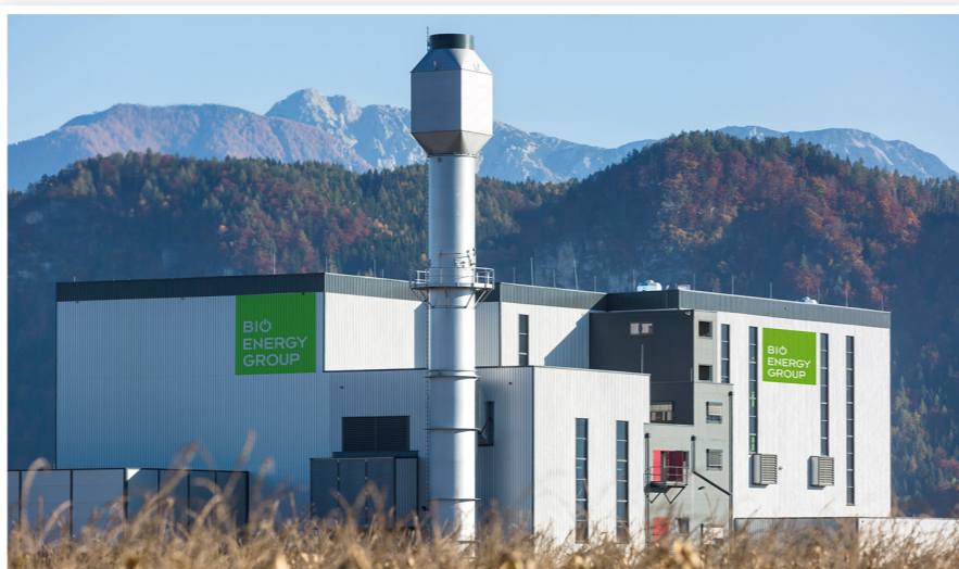
Seit der Inbetriebnahme des Biomasseheizkraftwerkes Klagenfurt Ost deckt Biomasse etwa 90 % des Fernwärmebedarfes der Kärntner Landeshauptstadt.
