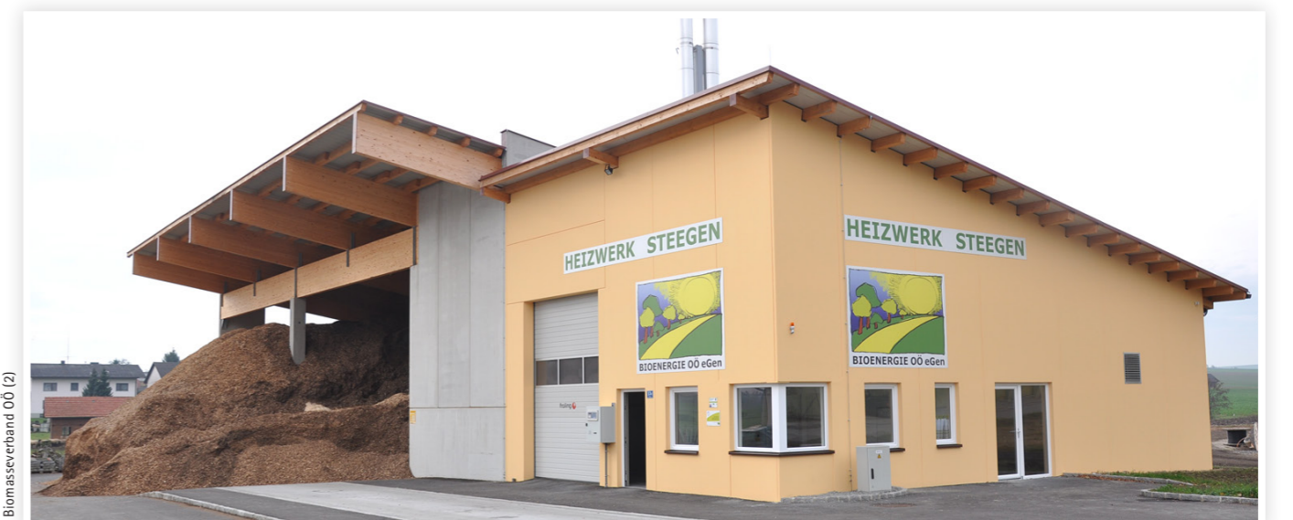
Seit 2012 versorgt dieses Biomasseheizwerk alle Gebäude des Instituts Caritas für Menschen mit Behinderungen St. Pius in Steegen mit erneuerbarer Wärme.
