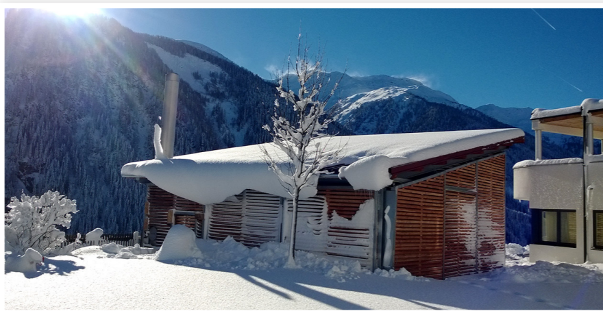
Das Heizwerk St. Veit im Defereggental beliefert seit 2013 das Dorfzentrum mit Holzwärme.
