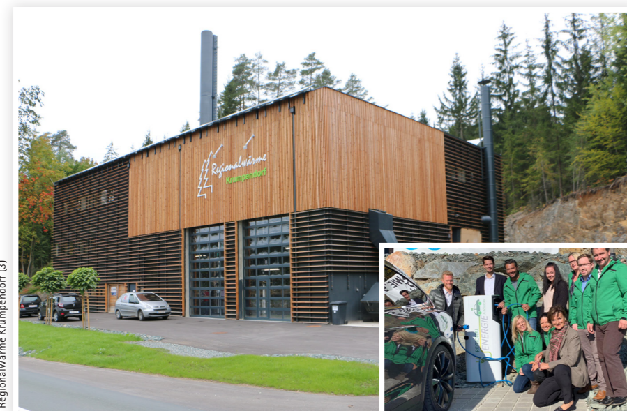
Gute Wärme kommt aus der Region: das Heizwerk Krumpendorf (E-Ladestation im kleinen Bild)
