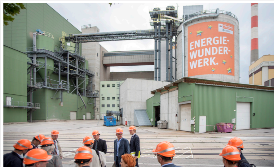
Das Waldbiomassekraftwerk Simmering ist mit einer elektrischen Leistung von 24 MW das größte Biomassekraftwerk Österreichs.
