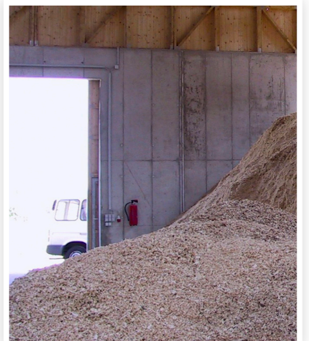
Lagerraum für Hackschnitzel
