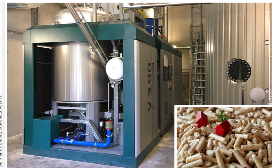
Die Burkhardt-Holzvergaser V 3.90 erzeugen zusammen mit den Blockheizkraftwerken ECO 165 HG (Ottomotoren) elektrische und thermische Energie aus Holzpellets für Bad Bleiberg.
