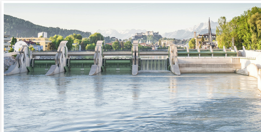
© Salzburg AG Das 2013 gebaute Wasserkraftwerk Sohlstufe Lehen versorgt etwa 23.000 Haushalte mit Strom; das Land Salzburg plant bis 2020 einen Ausbau der Wasserkraft um sechs derartige Kraftwerke.
