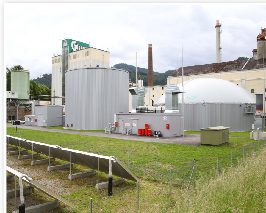
Das Gelände der Brauerei mit Solarkollektoren und Biertrebervergärungsanlage
