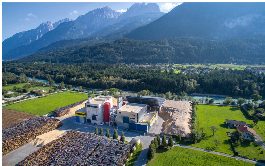
Das 2001 in Betrieb genommene Biomasseheizkraftwerk in Lienz versorgt 75 % der Haushalte im Stadtgebiet von Lienz und der Marktgemeinde Nußdorf/Debant ganzjährig mit Wärme und Strom.
