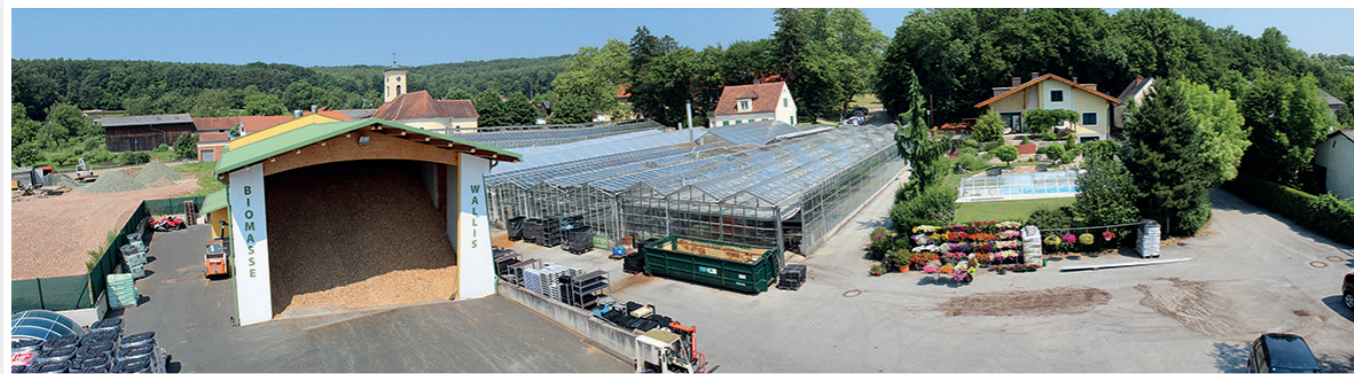
Die Hackgutanlage des Gärtnereibetriebes beliefert das Gewächshaus, das Verkaufszentrum und zehn Privathaushalte ganzjährig mit Wärme.
