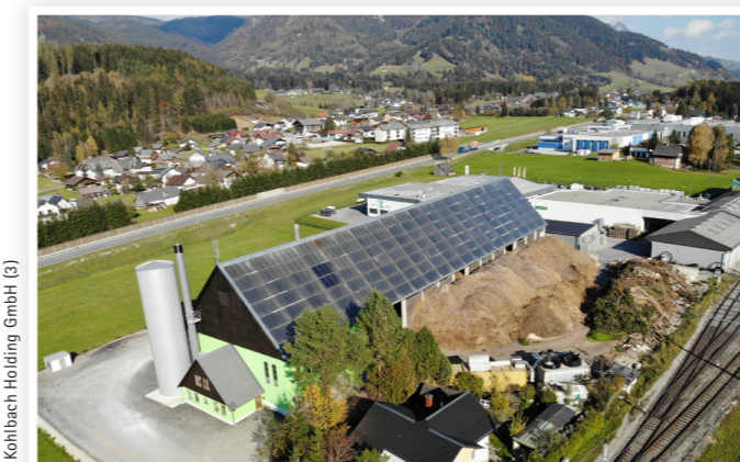
Bei der Modernisierung des Heizwerks der Biowärme Bad Mitterndorf wurden Solarthermie, Abwärme und Wärmerückgewinnung mit eingebunden.
