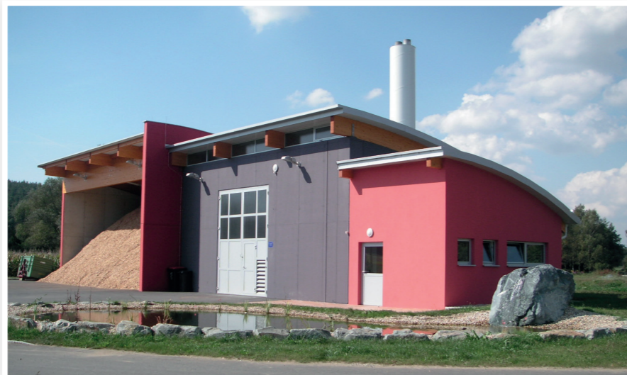
Das 2005 gegründete, von einer Genossenschaft betriebene Heizwerk in St. Martin in der Wart versorgt mit zwei 500-kW-Kesseln etwa 70 Einfamilienhäuser mit Wärme.
