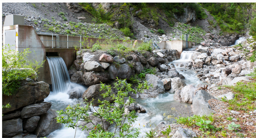
Das Kraftwerk Tegelsbach in Nassereith ist eines von rund 900 Kleinwasserkraftwerken in Tirol.
