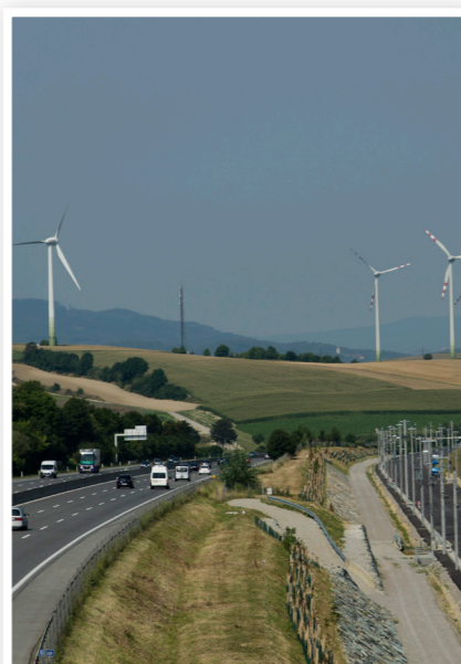
Windpark Haindorf: Niederösterreich ist das Bundesland mit der größten Windkraftproduktion.
