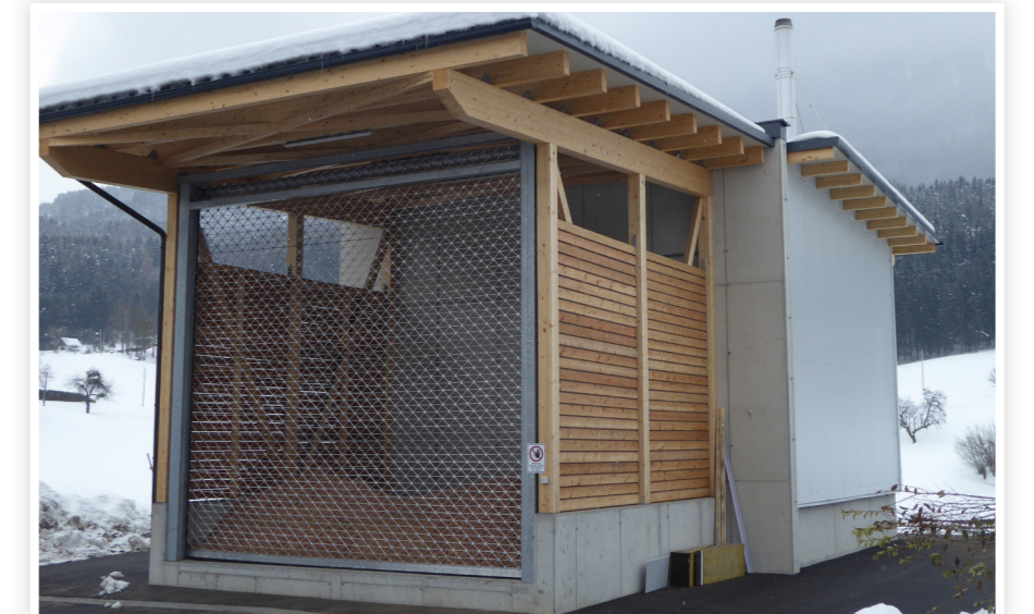
Frontansicht des Heizhauses in St. Margareten im Rosental
