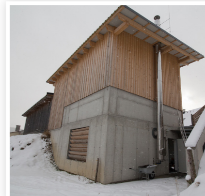
Das neue Heizhaus beherbergt die Windhager-Hackgutvergaser und das Hackschnitzellager.
