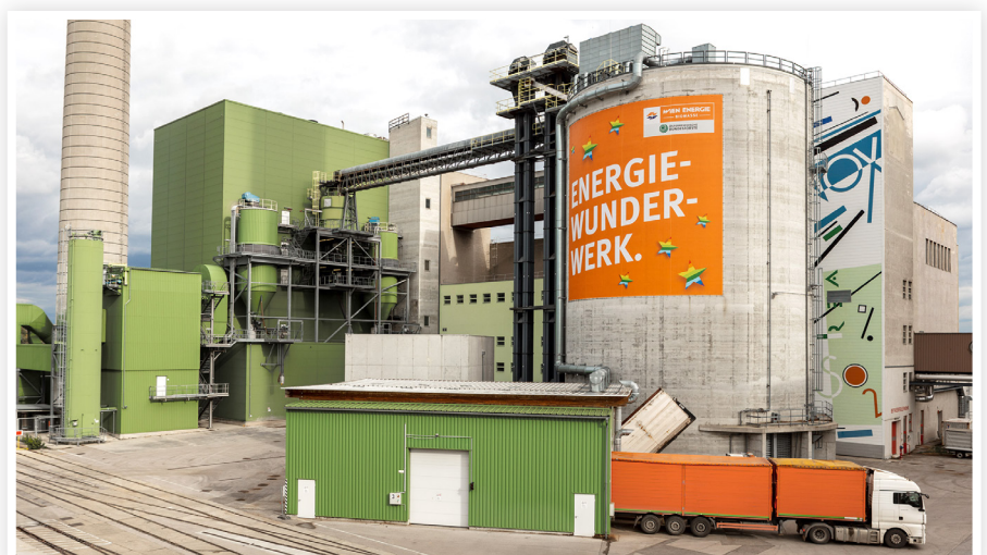
Das Waldbiomassekraftwerk Simmering ist mit einer elektrischen Leistung von 24 MW das größte Holzkraftwerk Österreichs.
