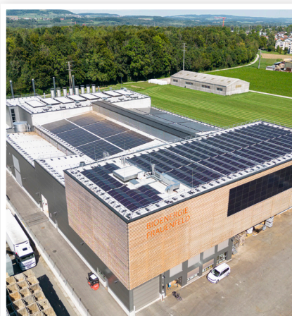
Das derzeit größte Rückwärtskraftwerk steht in der Schweiz bei der Bioenergie Frauenfeld AG.
