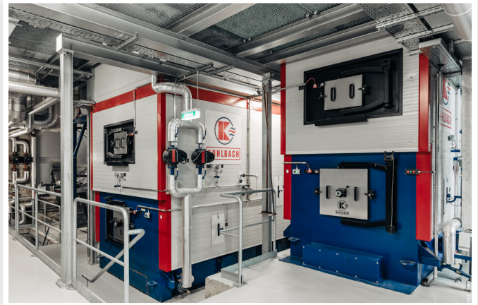
Pamela Eder und Geschäftsführer Herbert Hansmann, Biowärme Bad Mitterndorf, sind mit der Robustheit und Qualität der Kohlbach-Kessel sehr zufrieden. Für die Wärmeversorgung von 400 Kunden in Bad Mitterndorf inklusive der Aldiana-Grimmingtherme sorgen zwei Kohlbach-Kessel mit 5,5 MW.
