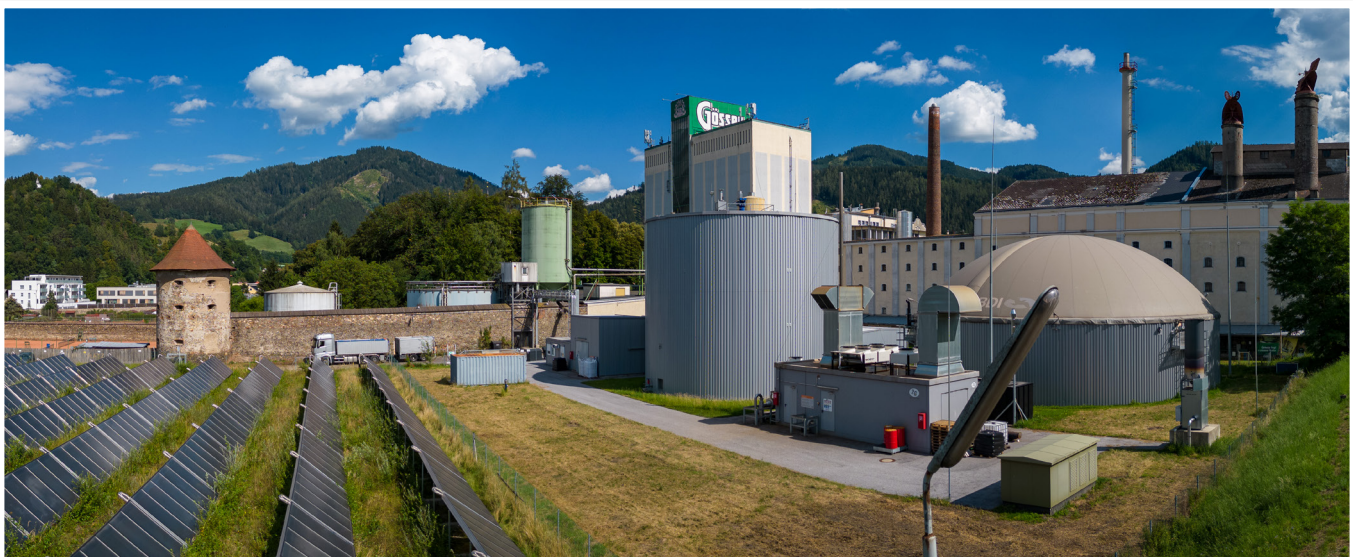
Das Gelände der Brauerei mit Solarkollektoren und Biertrebervergärungsanlage
