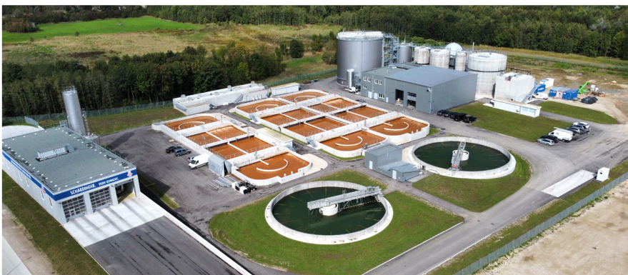
Die neue Abwasserreinigungs- und Biogasanlage in Aschbach
