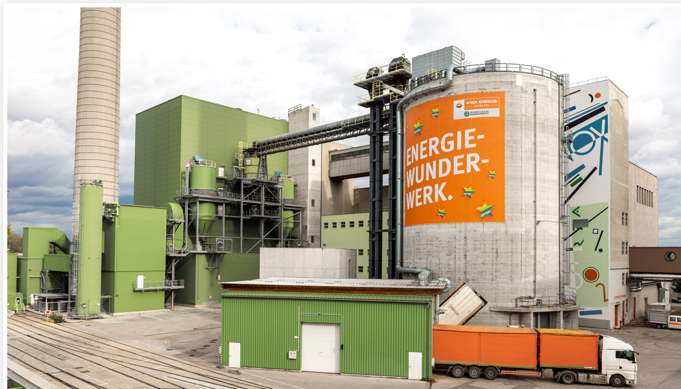
Mit einem Gesamtwirkungsgrad von bis zu 80 % werden in Wien-Simmering Strom und Wärme aus Waldhackgut erzeugt.
