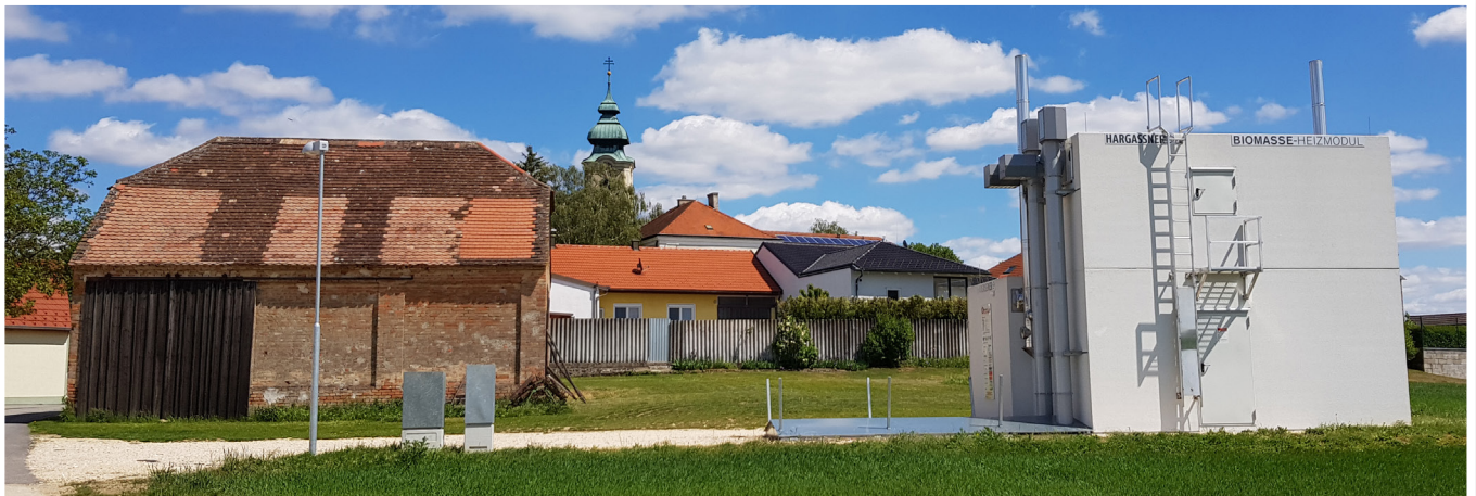
In Gnadendorf wurde am Ortsrand eine flexible Containerlösung als Wärmeversorgungszentrale errichtet.
