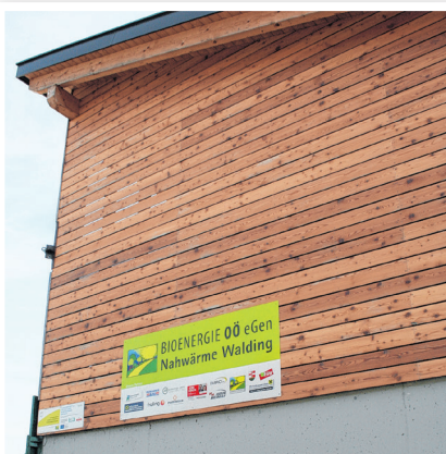
Das Heizwerk in Walding wird unter dem Dach der Genossenschaft Bioenergie OÖ betrieben.
