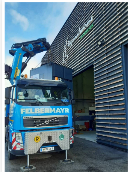
Anlieferung des neuen Hackgutkessels, mit dem die Leistung des Heizwerks auf 10 MW erhöht wird.
