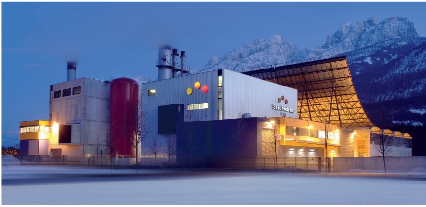
Die Biomasseheizkraftwerke Lienz I und II erzeugen jährlich 6,9 GWh Strom und 92 GWh Wärme, mit der über ein Wärmenetz von 65 km mehr als 5.000 Einzelkunden versorgt werden.
