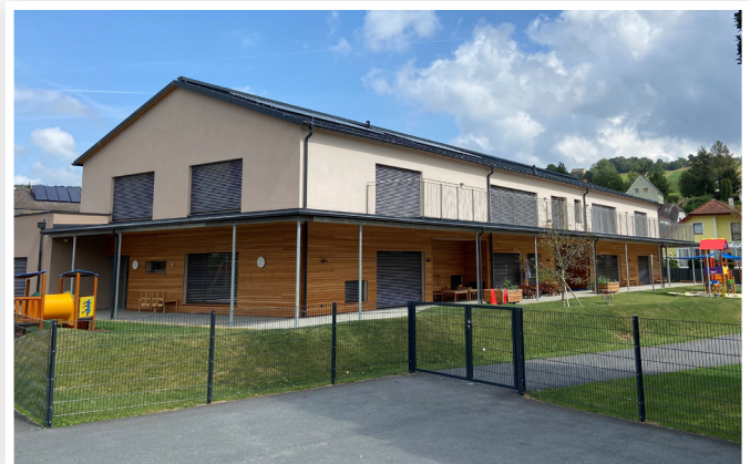
Für den neuen Pinggauer Kindergarten planten Ringhofer & Partner die Heizungs-, Lüftungs-, Sanitär- und Elektroinstallationen.
