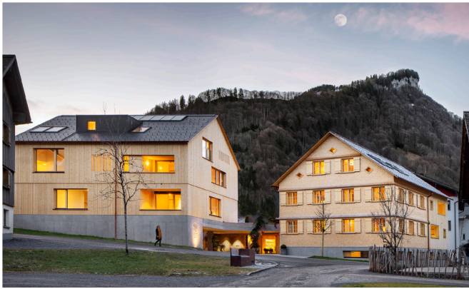
Solarthermie am Dach und ein Biomasseheizwerk sorgen im, mit dem Holzbau- preis prämierten, Apartmenthaus Tempel 74 im Bregenzerwald für Wärme.
