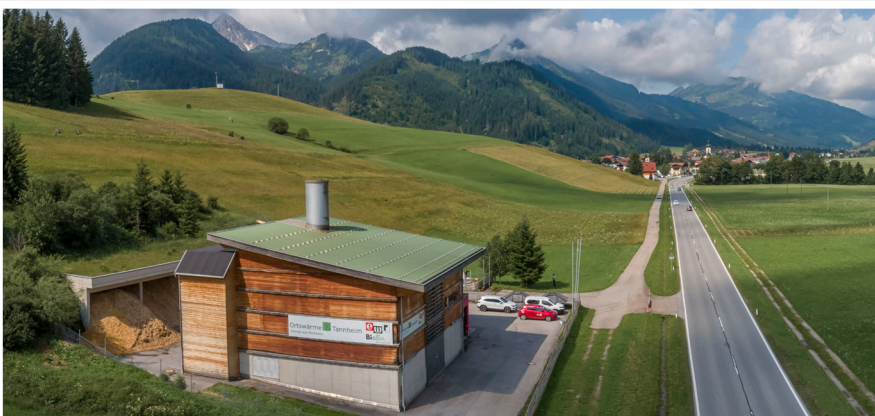
Die Ortswärme Tannheim im Bezirk Reutte beliefert mit einem 4,5-MW-Biomassekessel rund 140 private und gewerbliche Kunden in Tannheim und Grän mit Wärme aus regionaler Biomasse.
