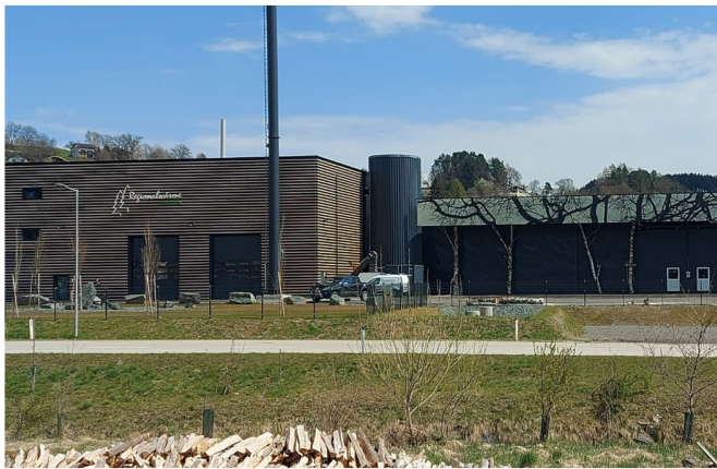
In Feldkirchen ist seit Oktober 2020 eines der innovativsten Heizwerke Kärntens in Betrieb.
