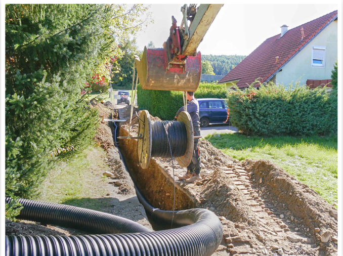
Austroflex – Netzerweiterung mit AustroPUR Plus Doppelleitungen
