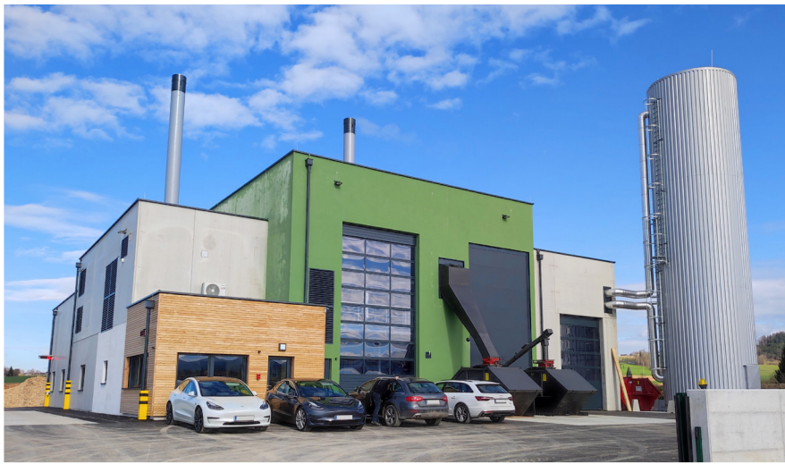
Das von Ringhofer & Partner geplante Biomasseheizwerk mit Heizzentrale, Pufferspeicher und vorisolierten Rohren wird ab 2023 die Gemeinde St. Georgen mit regionaler Fernwärme versorgen.
