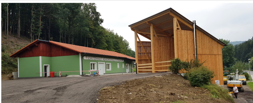
In Stössing wurde bereits die dritte eigenständige Biomasse-Wärmeanlage innerhalb des Gemeindegebietes installiert.
