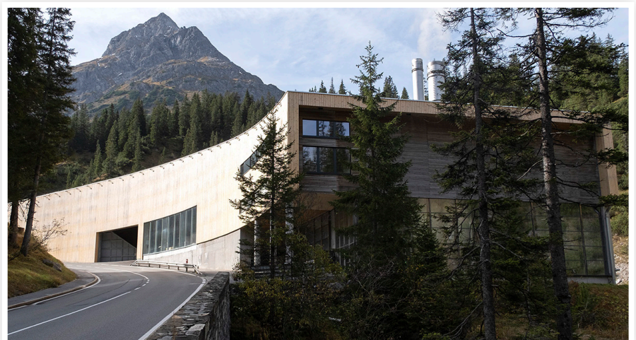
Im Wintersportort Lech am Arlberg versorgt das 2022 nach einem Brand wieder neu aufgebaute Biomasseheizwerk über ein 25 km langes Netz etwa 350 Objekte mit Fernwärme.
