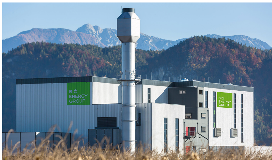
Seit der Inbetriebnahme des Biomasseheizkraftwerkes Klagenfurt Ost deckt Biomasse mehr als 80 % des Fernwärmebedarfes der Kärntner Landeshauptstadt.
