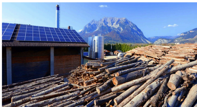
Seit 1991 versorgt die Biowärme Irnding über ein Leitungsnetz von 25 km etwa 90 % von Irnding und Raumberg mit Wärme aus regionalem Waldhackgut.
