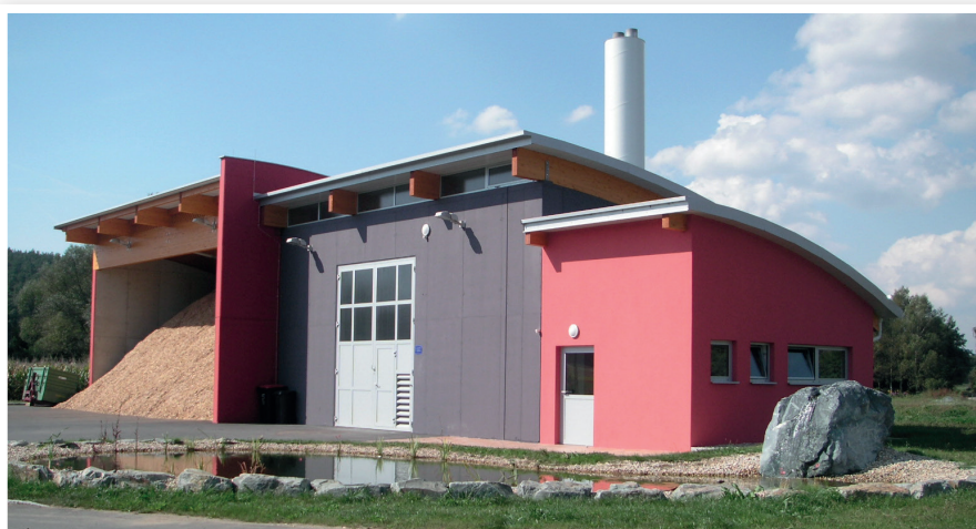
Das 2005 gegründete, von einer Genossenschaft betriebene Heizwerk in St. Martin in der Wart versorgt mit zwei 500-kW-Kesseln etwa 70 Einfamilienhäuser mit Wärme.
