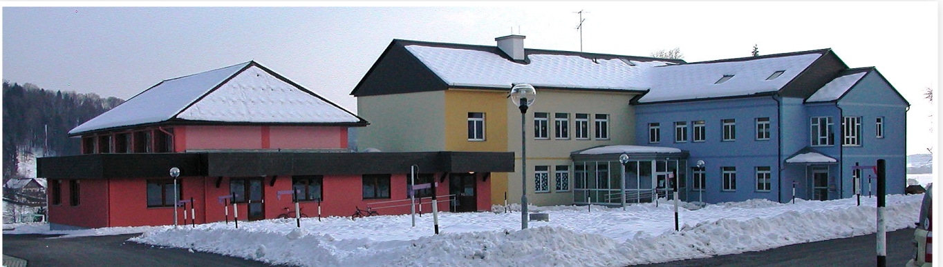
Das Ortszentrum von Empersdorf/Südsteiermark: Vier örtliche Landwirte versorgen mit Waldhackgut das Gemeindezentrum – mit 160 kW Leistung.
