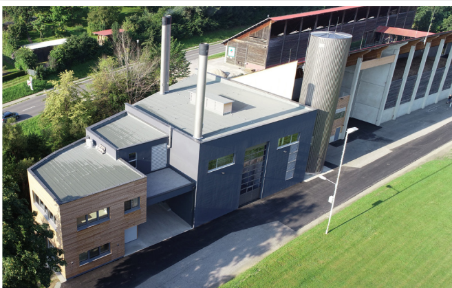
Beim Biomasseheizwerk Eibiswald konzipierten Ringhofer & Partner den Neubau der Heizzentrale mit zwei Biomassekesseln und einer Solaranlage.
