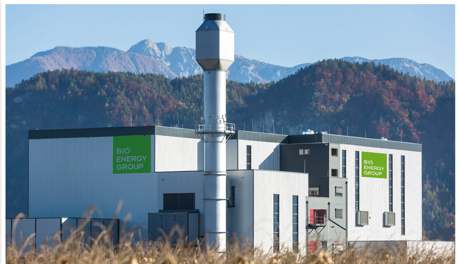
Seit der Inbetriebnahme des Biomasseheizkraftwerkes Klagenfurt Ost, deckt Biomasse etwa 90 % des Fernwärmebedarfes der Kärntner Landeshauptstadt.
