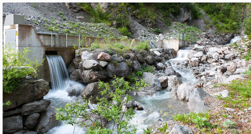
Das Kraftwerk Tegesbach in Nassereith ist eines von rund 900 Kleinwasserkraftwerken in Tirol.
