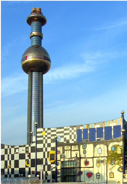
Die Müllverbrennung in Spittelau wandelt jährlich 250.000 Tonnen Hausmüll in Wärme und Strom um.
