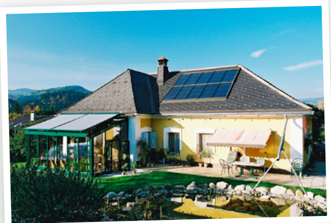
Auch bei Erweiterung der Wohnfläche ist eine einfache Anpassung der Leistung möglich.
