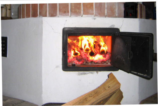
Die Verwendung eines Kachelofens in Kombination mit einem Biomasse-Nahwärmeanschluss ist problemlos möglich.
