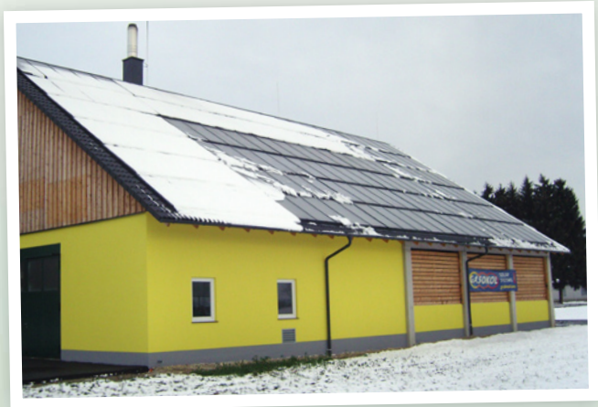
Im Sommer sorgt die thermische Solaranlage für Warmwasser, im Winter übernimmt die Biomasse diese Funktion.
