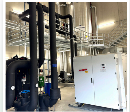
Die Wärmepumpe gewinnt Wärme aus dem gereinigten Abwasser und speist sie ins Netz ein.
