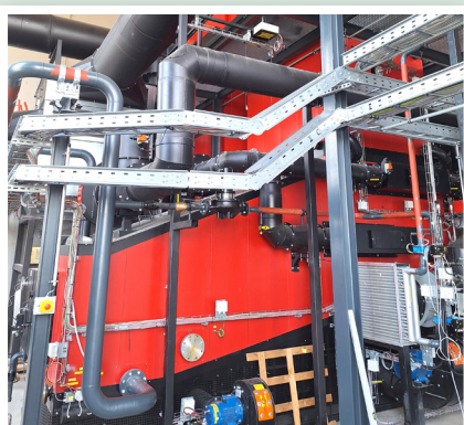
Ein 5-MW-Hackgutkessel ersetzt den fossilen Erdgaskessel und produziert positives CO 2 .
