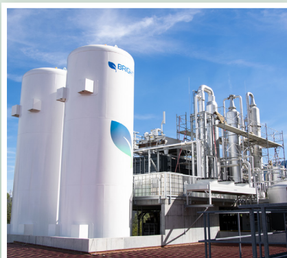
Jährlich werden in der Anlage 3.700 Tonnen CO 2 aus den Rauchgasen abgeschieden.
