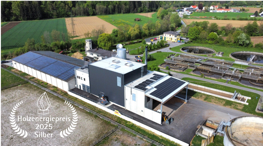
Das neue Biomasseheizwerk neben der Kläranlage Gleisdorfer Becken sorgt im Zusammenspiel mit der Abwasserwärmerückgewinnung für eine hohe Flexibilität der klimafreundlichen Wärmebereitstellung.
