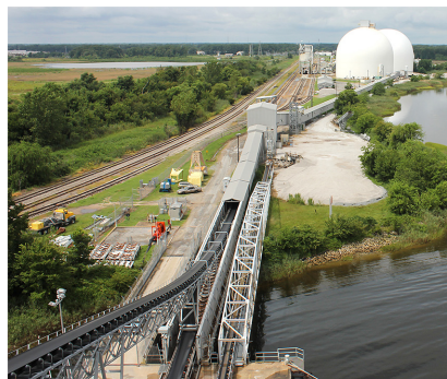
Über Förderbänder werden die Pellets aus den Domes zu den Schiffen transportiert.
