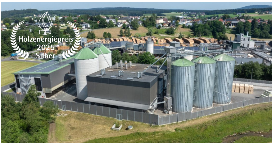
Das Pelletswerk der Holzindustrie Stallinger steht für moderne, nachhaltige und energieeffiziente Holzverarbeitung – modernste Filtertechnik erlaubt die unmittelbare Nähe zu einem Wohngebiet.
