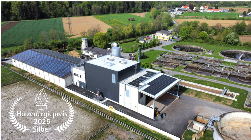
Das neue Biomasseheizwerk neben der Kläranlage Gleisdorfer Becken sorgt im Zusammenspiel mit der Abwasserwärmerückgewinnung für eine hohe Flexibilität der klimafreundlichen Wärmebereitstellung.
