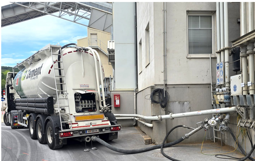
Einblasen der für das neuartige Brennen des Kalks eingesetzten Holzpellets
