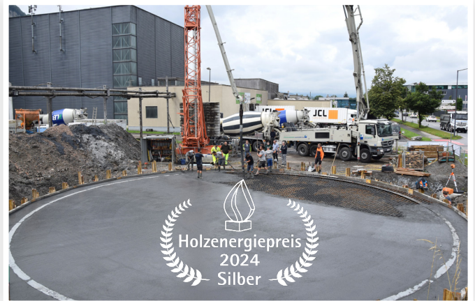
Das Fundament des Großwärmespeichers besteht aus Klimabeton, der mit technischem Kohlenstoff aus den eigenen Holzkraftwerken angereichert ist.
