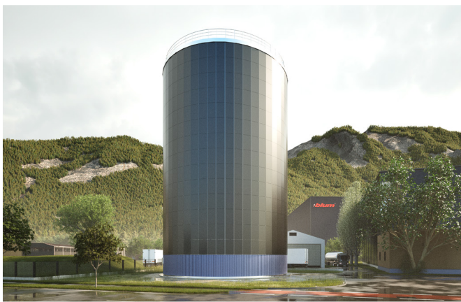
Der fast 30 m hohe neue Pufferspeicher in Dornbirn stellt mit den in der Fassade integrierten Solarmodulen auch einen PV-Leuchtturm dar.
