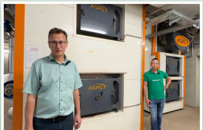
Geschäftsführer Christian Frühauf (li.) und Mario Rauter vor Haupt- und Sommerkessel – eine Abgaszirkulation erhöht den Wirkungsgrad deutlich.
