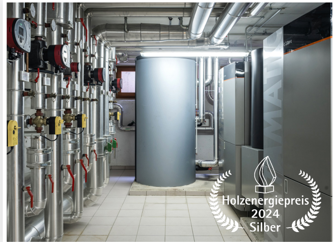
Aus alt wurde neu: die fertiggestellte Pelletsheizung mit zwei Heizkessel von Guntamatic mit je 100 kW Leistung samt Pufferspeicher
