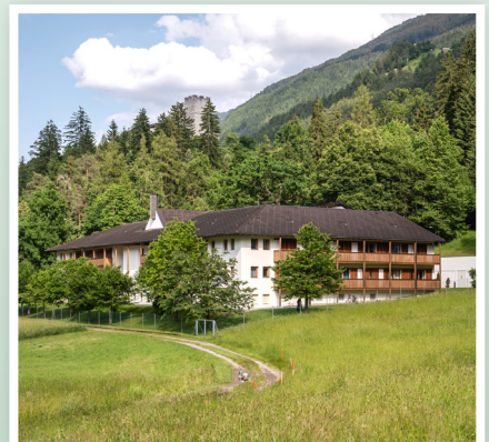
Das Ordenshaus der Schwesterngemeinschaft vom Heiligen Kreuz erhielt eine moderne Pelletsheizung.
