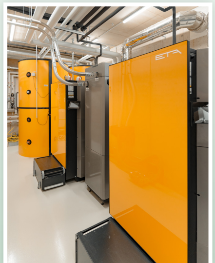
Die ETA-Pelletsheizung versorgt über ein Nahwärmenetz elf Häuser und Verwaltungsgebäude.
