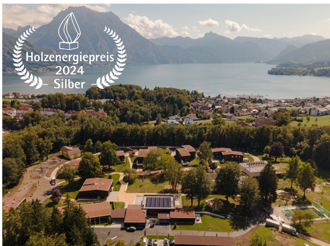
Beim Dorfneubau entstanden in Altmünster am Traunsee elf nachhaltige Baukörper nach neuesten ökologischen und technischen Standards.
