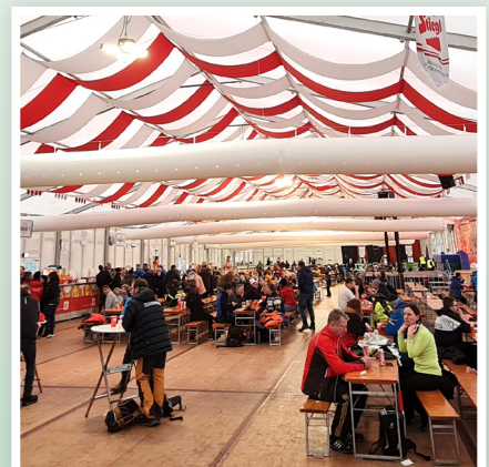
Elf Hargassner-Heizcontainer brachten wohlige und erneuerbare Wärme in die Zeltlandschaft.
