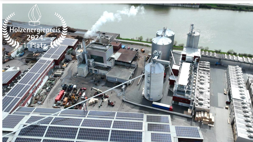
Das Pelletswerk (rechts) der Donausäge Rumplmayr befindet sich direkt neben dem Biomasse-Heizkraftwerk – ein 170 m langes Förderband transportiert die Sägespäne vom Sägewerk zum Nassspannsilo.
