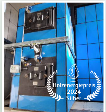
Die stehende Konstruktion des Wärmetauchers neben der Feuerung verbessert den Wirkungsgrad.
