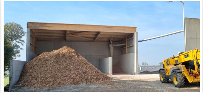
Regionales Hackgut wird per Lkw oder Anhänger zum Brennstofflager geliefert; über Schubstangen und Querförderer gelangt es in die Feuerung.
