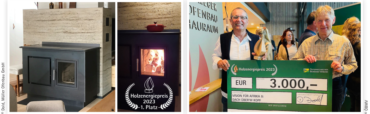
Ein Teil der Ofenhülle ist mit gestampftem Lehm ausgeführt und sorgt für die schwere Masse des Speicherofens, der auch als Kochgelegenheit dient. Über die Auszeichnung mit dem Holzenergiepreis des Biomasse-Verbandes freuen sich Bauherr Dietmar Dold (li.) und sein Installateur Gebhard Keckeis.
