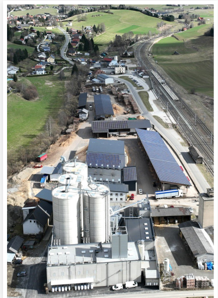
Standort Neumarkt mit vier 30 m hohen Lagersilos (Nassspan-, Trockenspan- und zwei Pelletssilos)
