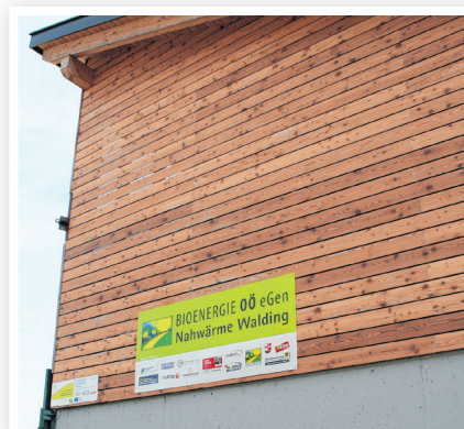
Das Heizwerk in Walding wird unter dem Dach der Genossenschaft Bioenergie OÖ betrieben.
