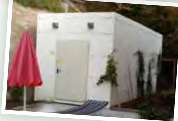
Beim Hotel Hochzillertal ist der Container Heiz- und Lagerraum für Pellets zu- gleich.
