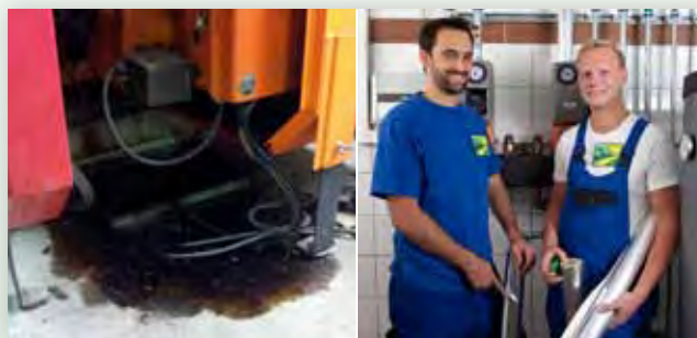
Die alte Ölheizung hat ausgedient (li.); Biowärme-Installateure beraten Sie gerne beim Einbau einer Holzheizung.
