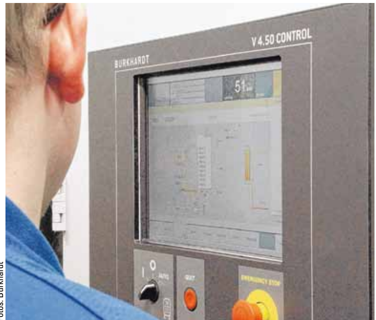
Der Touchscreen des Holzvergaser erlaubt einen schnellen Zugriff auf alle wichtigen Parameter – ein Fernzugriff ist jederzeit möglich.
