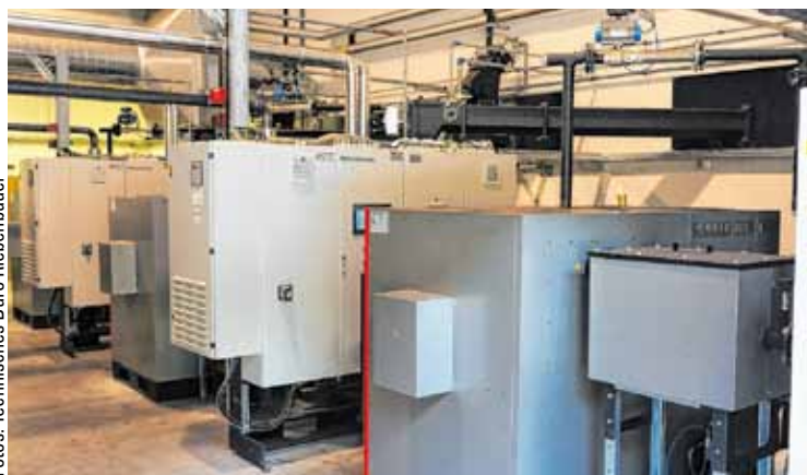
In Kaskade geschaltete Holzvergaseranlagen in Wenigzell erhöhen zusätzlich die Flexibilität.
