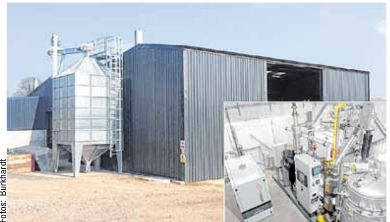
Charltons (Großbritannien): Der erzeugte Strom der 50 kW-Burkhardt-Anlage wird vor Ort zu 100 % genutzt, und die Wärme dient der Hackschnitzeltrocknung.
