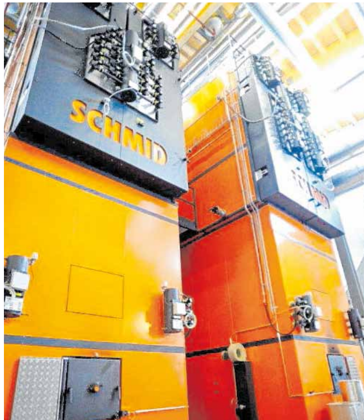
Höchste Energieeffizienz, Zuverlässigkeit und Langlebigkeit charakterisieren die Anlagen von Schmid energy solutions.
