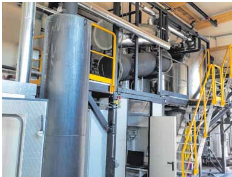
Neue Holzvergaseranlage im steirischen Pöllau.
