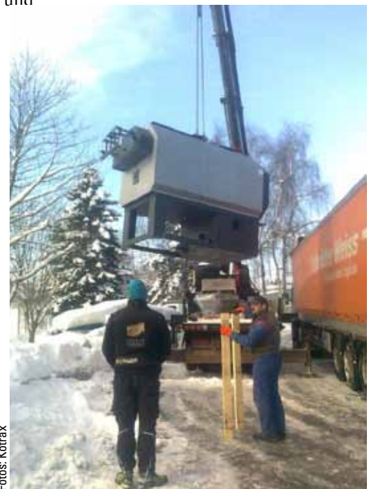
Der 540-kW-Biomasse-Kessel erspart 40.000 Liter Heizöl und 108 Tonnen CO 2 im Jahr.
