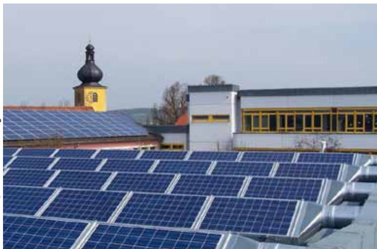
Auf gleicher Dachfläche könnten mit PVT-Modulen 15 % mehr Leistung erzielt werden.
