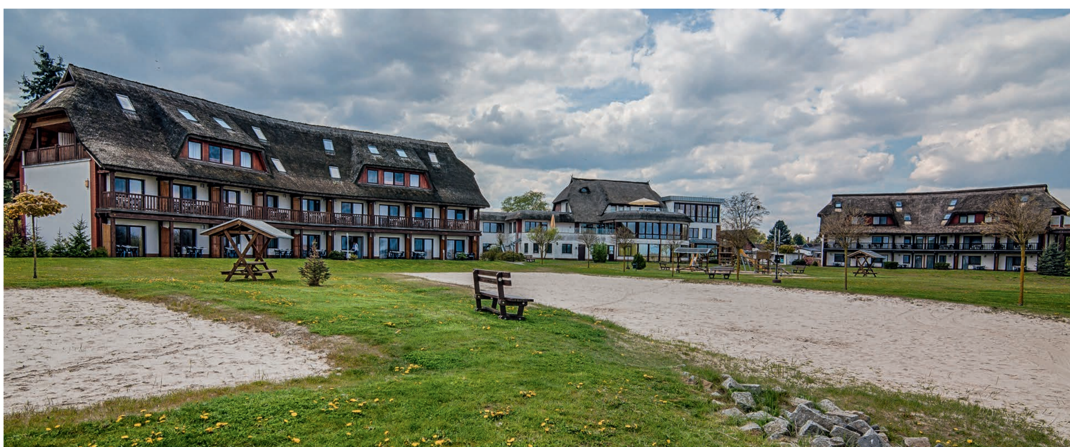
Das Haffhus im Seebad Ueckermünde an der Ostsee versorgt sich eigenständig mit Wärme und Strom.
