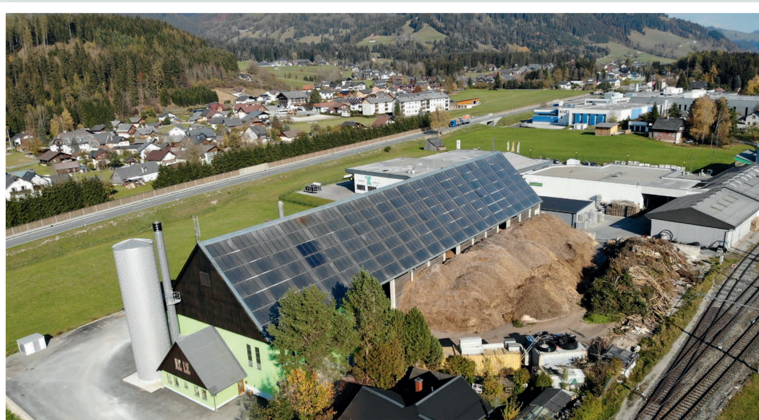
Bei der Modernisierung des Heizwerks der Biowärme Bad Mitterndorf wurden Solarthermie, Abwärme und Wärmerückgewinnung mit eingebunden.
