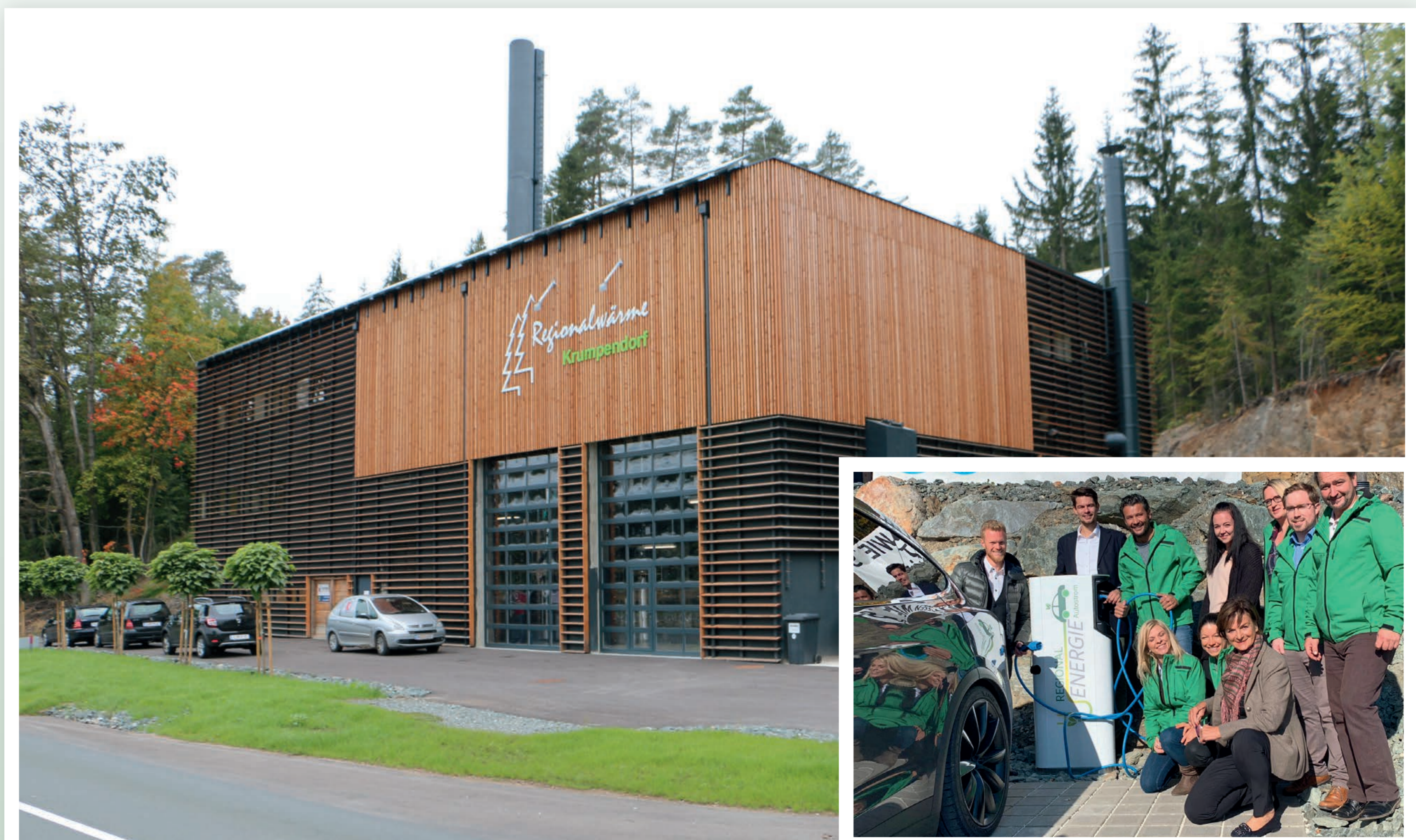
Gute Wärme kommt aus der Region: das Heizwerk Krumpendorf (E-Ladestation im kleinen Bild)
